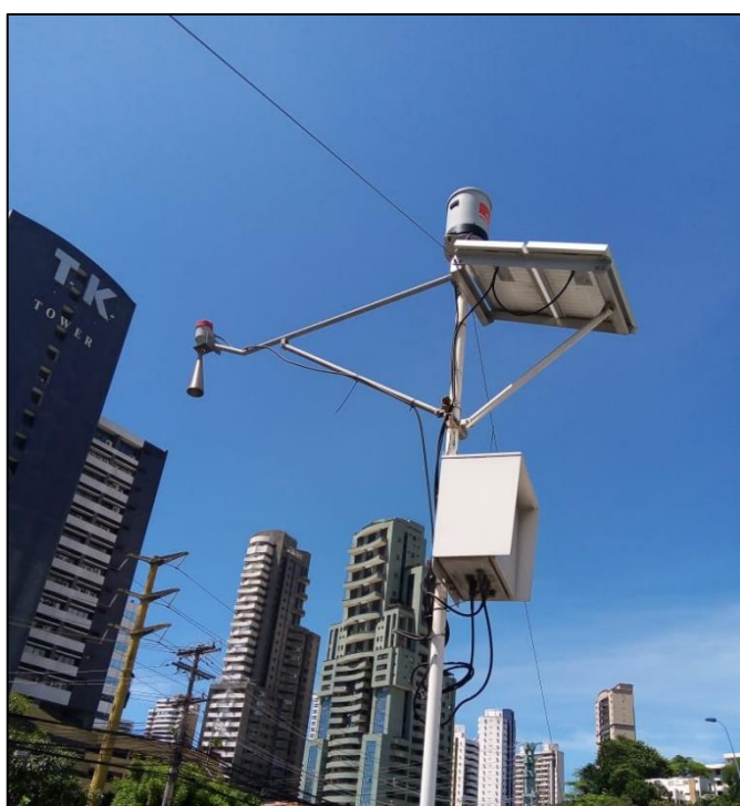
Figura 48 - Exemplo Estação Hidrológica Online - Pluviômetros e Sensor de Nível de Canal de Macrodrenagem
